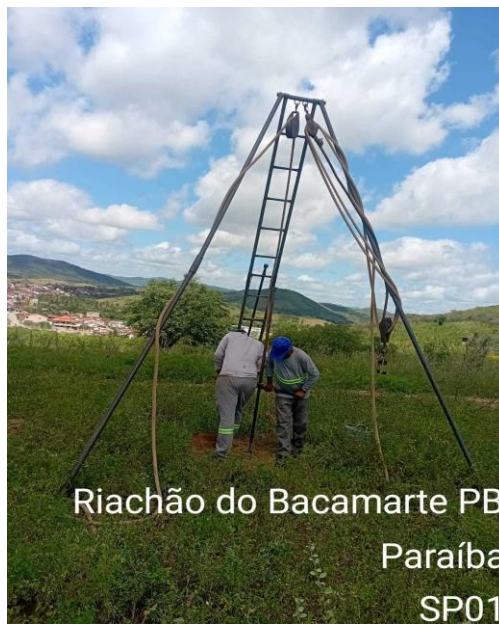
FIGURA 2: EXECUÇÃO DE SONDAGEM EM RIACHÃO DO BACAMARTE/PB
