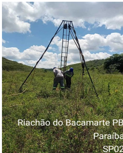
FIGURA 1: EXECUÇÃO DE SONDAGEM EM RIACHÃO DO BACAMARTE/PB
