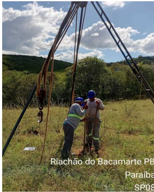
FIGURA 1: EXECUÇÃO DE SONDAGEM EM RIACHÃO DO BACAMARTE/PB
