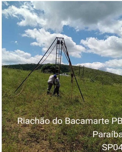
FIGURA 1: EXECUÇÃO DE SONDAGEM EM RIACHÃO DO BACAMARTE/PB
