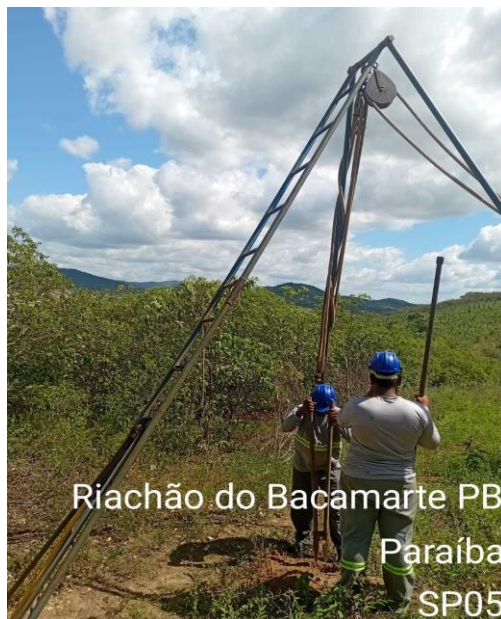
FIGURA 1: EXECUÇÃO DE SONDAGEM EM RIACHÃO DO BACAMARTE/PB
