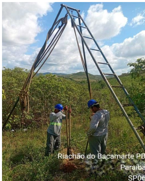
FIGURA 1: EXECUÇÃO DE SONDAGEM EM RIACHÃO DO BACAMARTE/PB
