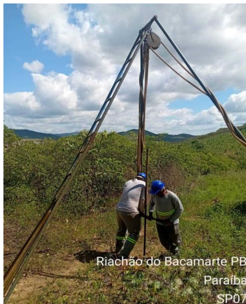
FIGURA 1: EXECUÇÃO DE SONDAGEM EM RIACHÃO DO BACAMARTE/PB
