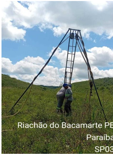
FIGURA 1: EXECUÇÃO DE SONDAGEM EM RIACHÃO DO BACAMARTE/PB
